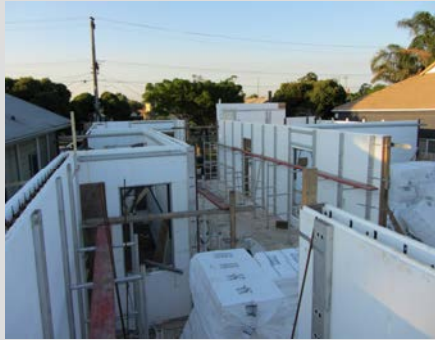
FormPro Walls before concrete pour
