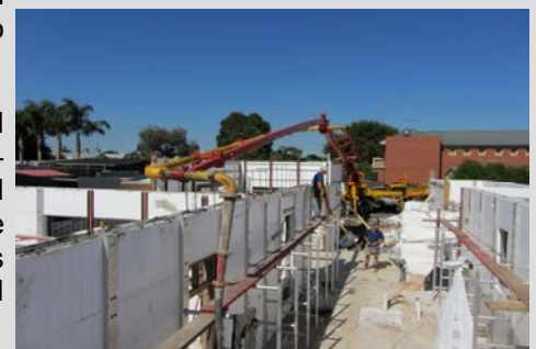
Ground Floor Wall Concrete Pour
